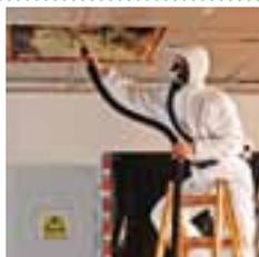
Um sicher zu gehen, dass Sie bei der Entfernung von asbesthaltigen Stäuben oder H-Klasse zertifizierten Stäuben die richtige Wahl treffen, verwenden Sie die Nilfisk-ALTO Sicherheitssauger der H-Klasse.
